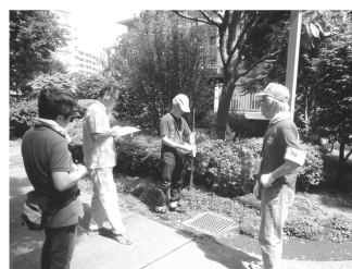
8-9号棟間 排水溝(集水桝)
